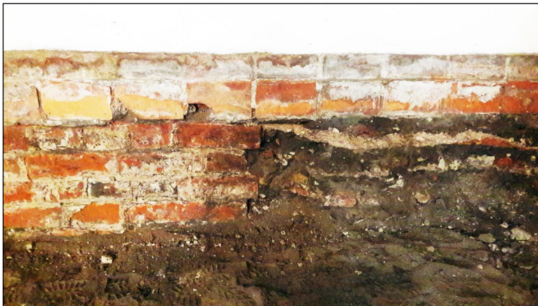
Afbeelding 28. Opname van het noordelijk gedeelte van de fundering van de westmuur van het schip. De vier baksteenlagen links vormen de fundering van toren en traptoren. De lengte van de grootste bakstenen is circa 31 cm. Rechts van de vertanding is de fundering van het schip te zien, bestaande uit vlijlagen. De bovenste twee lagen baksteen betreffen tegels die tegen de muur zijn geplaatst (foto: auteur)
