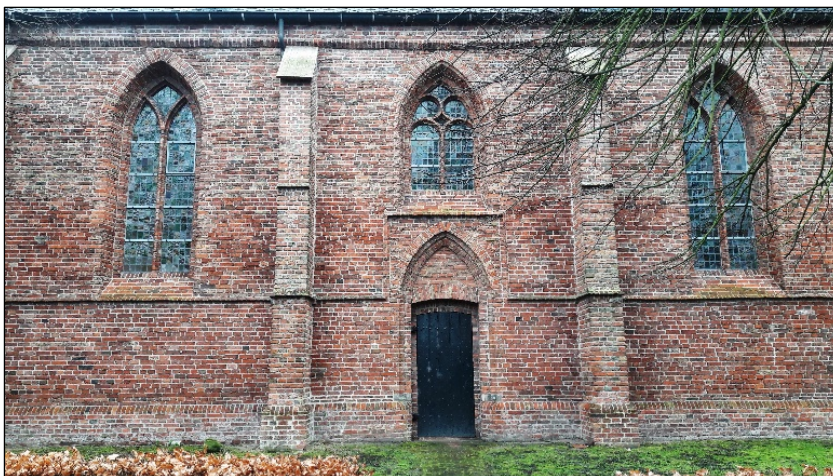
Afbeelding 30. De noordwand van het schip. Iets boven de helft van de muur verandert de baksteen van formaat. Mogelijk is het onderste deel gebouwd met baksteen die vrij kwam bij de afbraak van de Romaanse kerk (foto: auteur)
