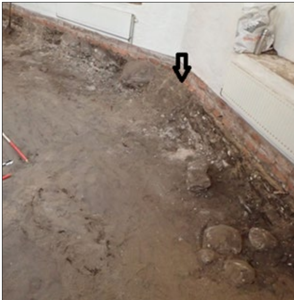
Afbeelding 7. Foto van de betonnen versterking (bij de pijl) van de koormuur. De fotorichting is noordwest
