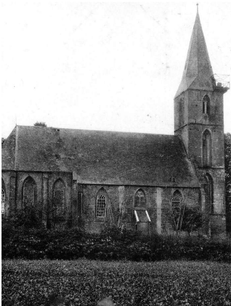
14. Noordkant: ook aan deze zijde waren de vensters van de koortraveeën dichtgezet en ontbreken er steunberen (foto RCE).
