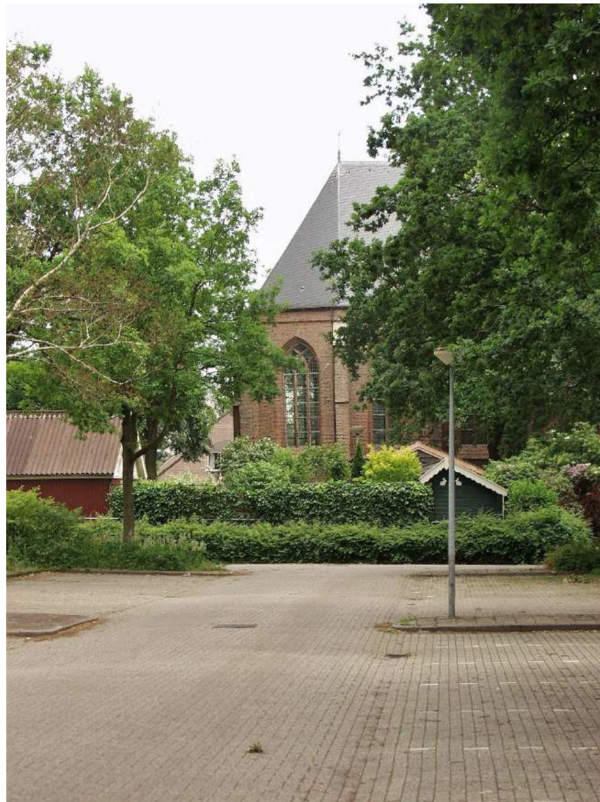
67. zicht op het koor vanaf de parkeerplaats.
