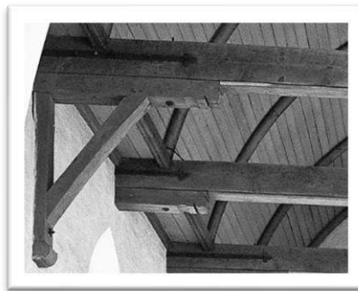
23 – 25. Boelens ontwerp voor de nieuwe korbeelstellen. Hij voorzag het sleutelstuk van een gotische peerkraal. De oorspronkelijke sleutelstukken waren echter in een vroeg-17 de -eeuws motief geprofileerd (inzet links). (afb. RCE, Bé van der Veen).
