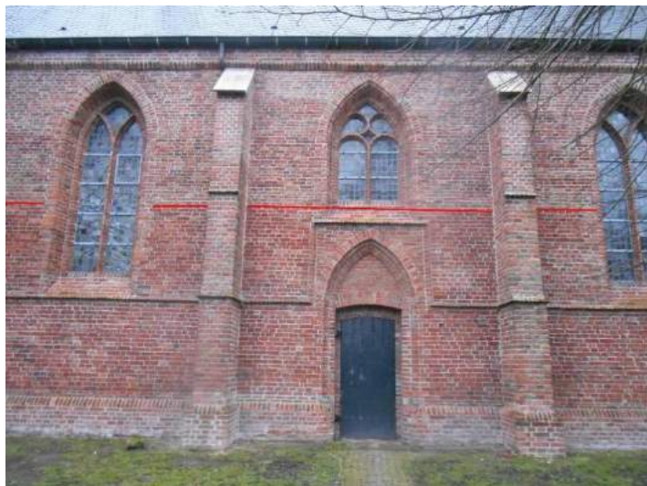
7. Noordzijde schip: grens tussen bouwfases.
