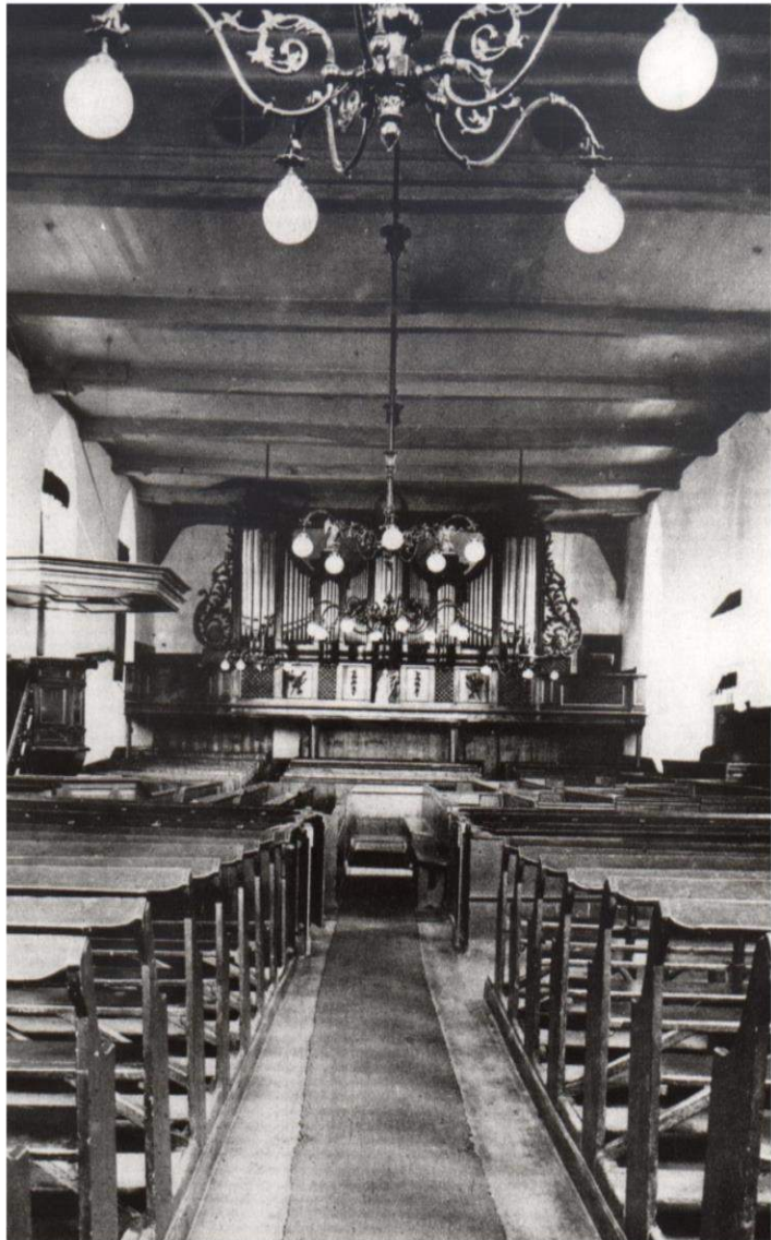
16. Deze interieurfoto van voor de restauratie toont nog het houten balkenplafond uit ca. 1610 (afb. Drents Archief).
